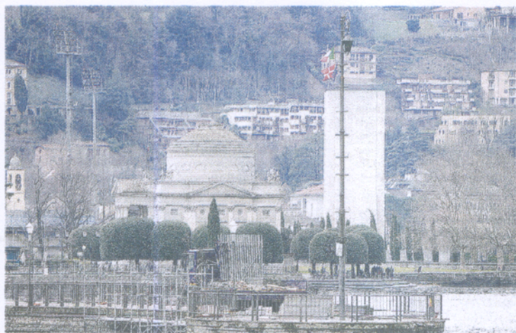
L'avvio dell'allestimento del cantiere in fondo alla diga POZZONI
