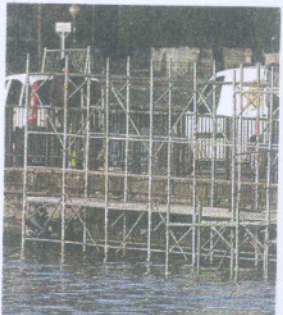
Uno dei sub al lavoro sulla diga ieri mattina
