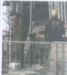
Daniele Brunati ieri sul cantiere della diga
