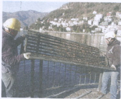
Sopra, due scatti forniti dagli "Amici di Como" che documentano l'allestimento del cantiere ieri mattina
