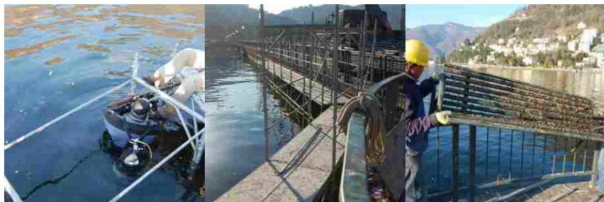
I sub si immergono per il ponteggio La prima istantanea del cantiere ...salta fuori anche una panchina!
