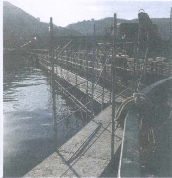
Prosegue intanto l'allestimento delle impalcature, a tre metri di profondità, attorno alla diga foranea
