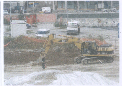
Operai al lavoro sull'area per la bonifica, costata oltre 5,5 milioni di euro
