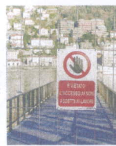
Primi lavori sulla diga foranea
